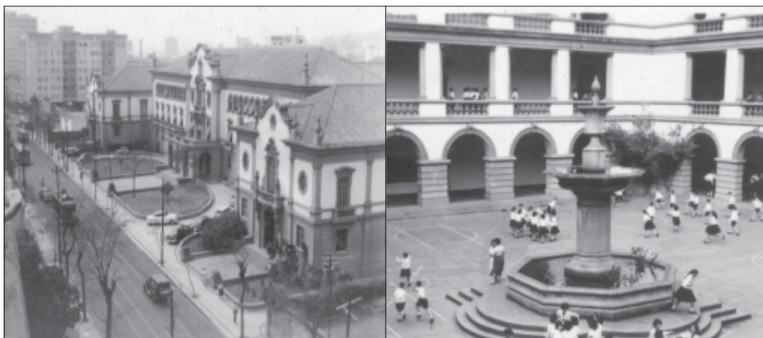
Fachada e pátio interno do Instituto de Educação do Rio de Janeiro
